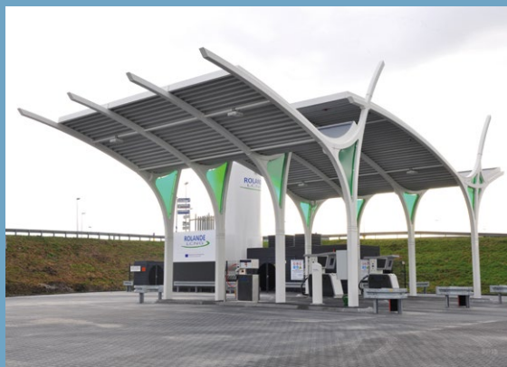
Nieuwste LNG-tankstation van Rolande LNG (Utrecht)
